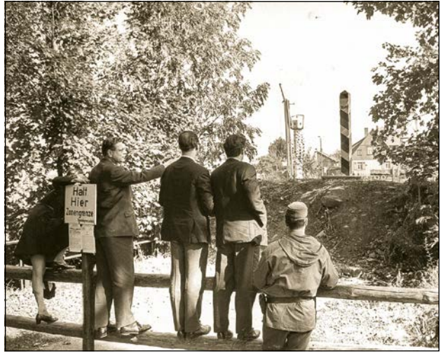
Menschen in Eckertal beobachten den Aufbau des neuen Betongrenzturmes 1969 (Bad Harzburg-Stiftung, Ahrens-Fotoarchiv, Foto: Herbert Ahrens)
